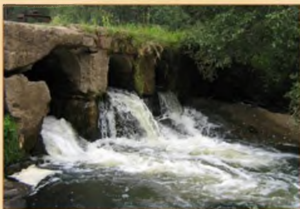
Плотина на Штолевском озере
